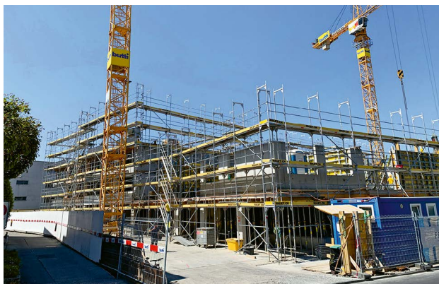
Die Baustelle in Lachen im Sommer 2020.
